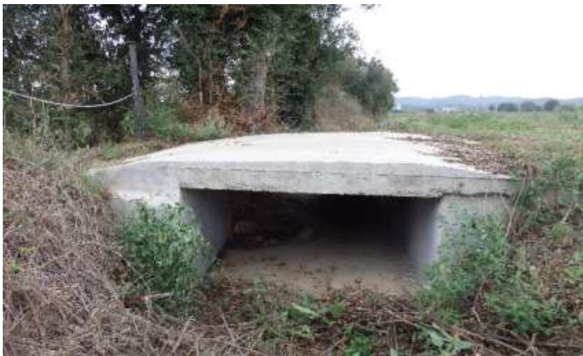
Dues vistes actuals del pont del rec madral (can Güitó Gros)
