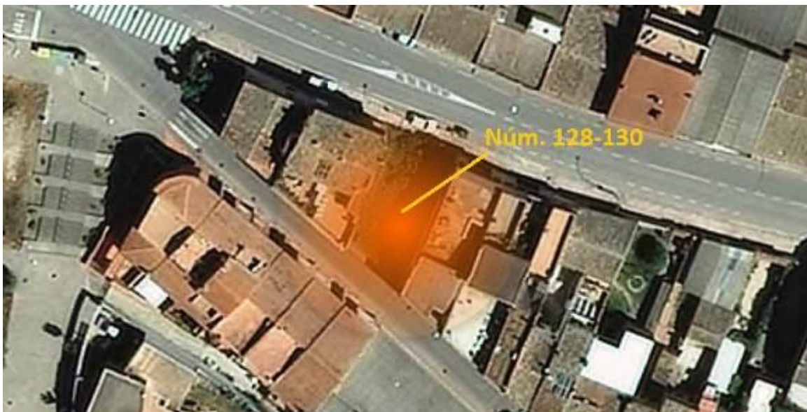
Danys que va provocar l'ona expansiva de la bomba 10 a la part baixa del carrer del Molí (Imatge Niell)
