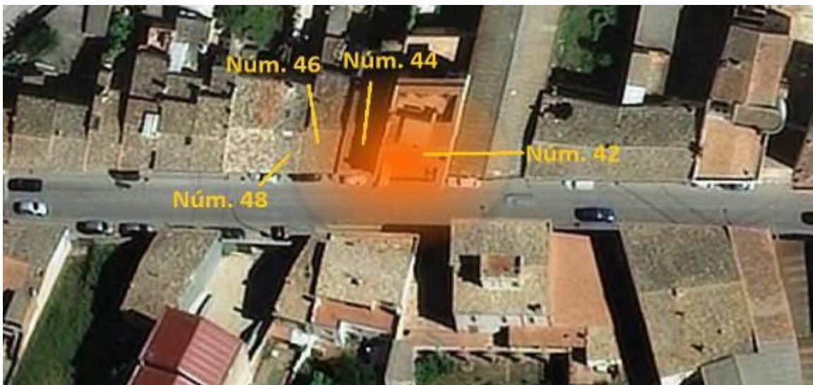
Danys que va provocar l'ona expansiva de la bomba 2 de la carretera Provincial (Imatge Niell)
