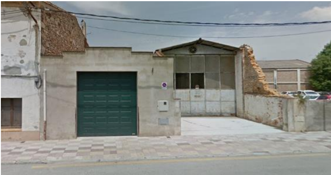
Vista frontal de l'edifici número 76 de la carretera Provincial (Foto Niell)
