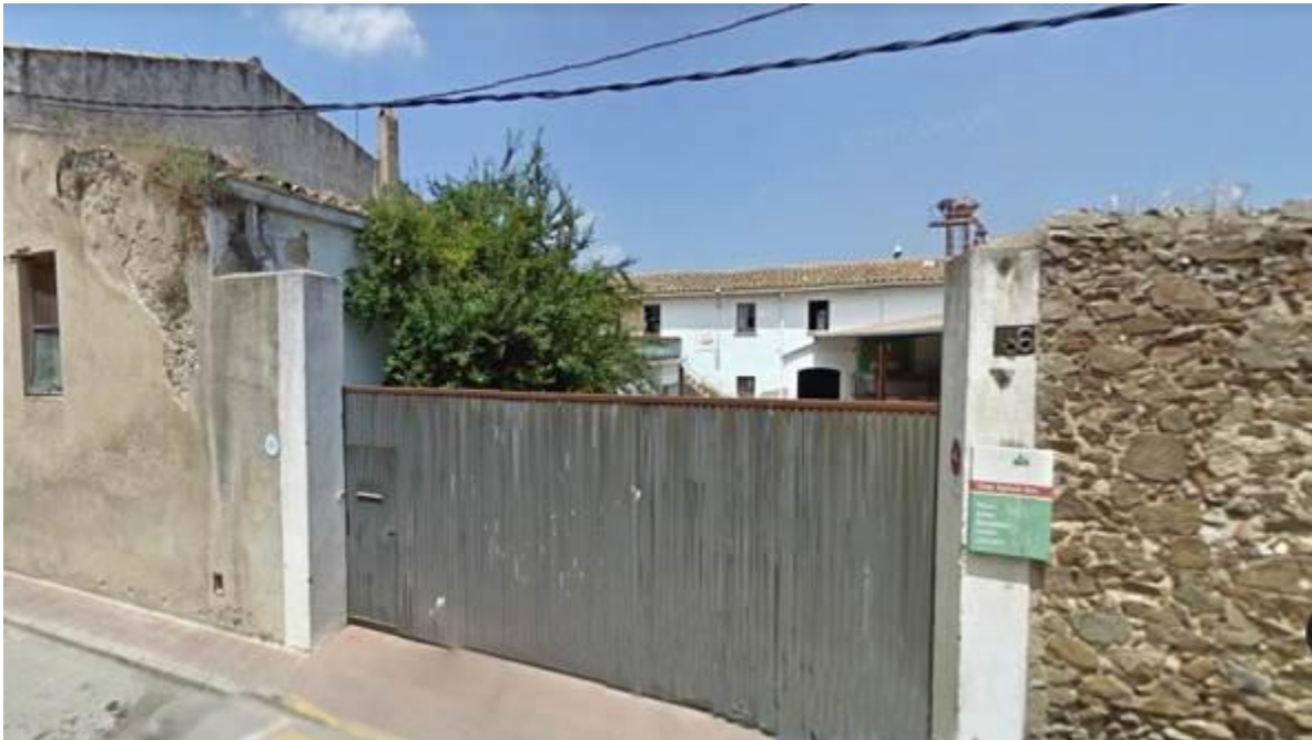
Vista frontal de l'entrada del molí o Sindicat Agrícola de Cassà (Foto Niell)
