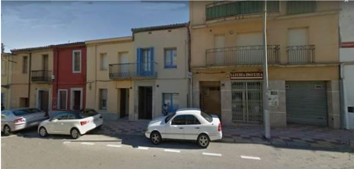
Vista general dels immobles número 42, 44, 46 i 48 de la carretera Provincial (Foto Niell)
