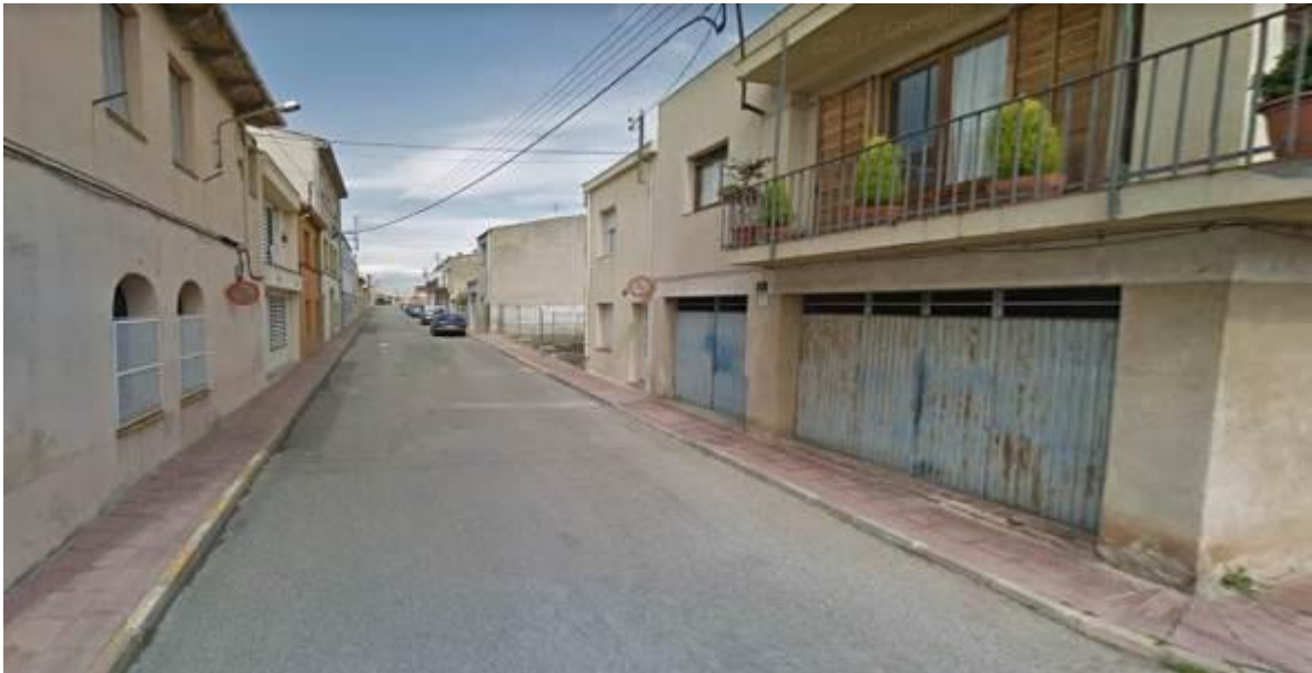
Vista general del carrer Barceloneta a l'alçada dels números 2, 4, 6 i 8 (Foto Niell)
