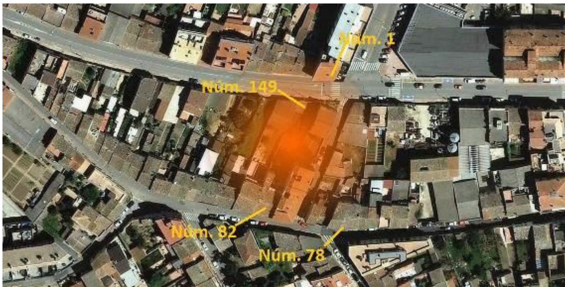
Danys que va provocar l'ona expansiva de la bomba 9 que va caure entre el carrer del Molí i la carretera Provincial (Imatge Niell)
