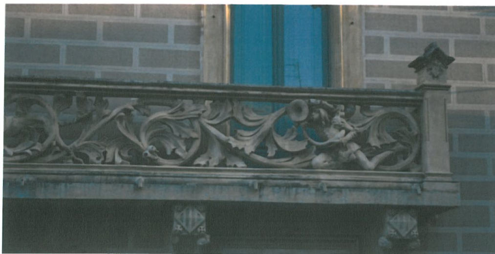
Fig. 40. Detall de la banda dreta de la balconada. Fotografia de l'autora.
